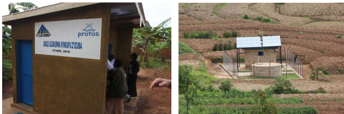
Figure 2 : Borne-fontaine et point de captage de Cyeza
